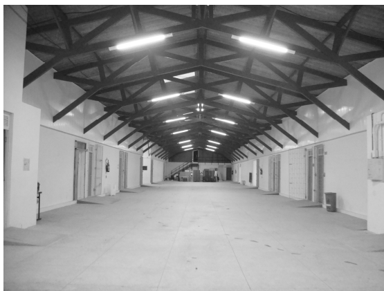
Foto 2: Galpão – espaço coberto.
